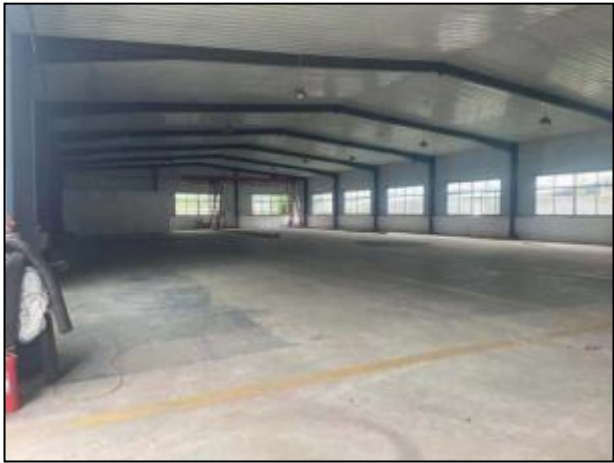
生产车间现状
